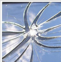
通常ガラスの割れ
